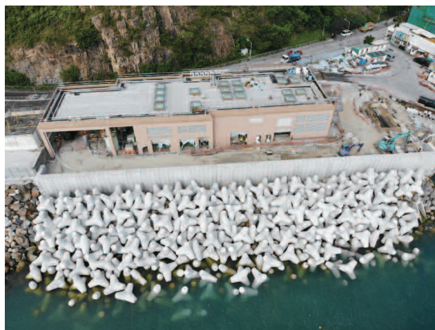
鴨脷洲初級污水處理廠海堤的四腳護堤塊
