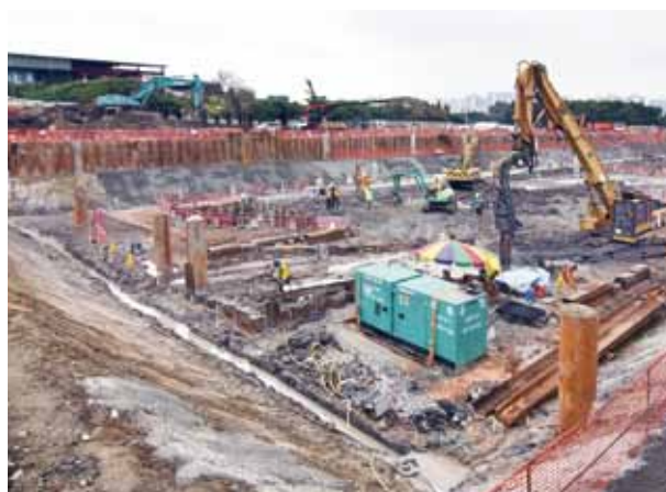
圖三：CEPT內部進行ELS施工
