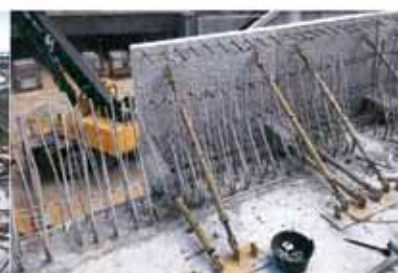
6. 最後安裝支撐固定 (須佩帶獨立救生繩並繫於穩固點)
