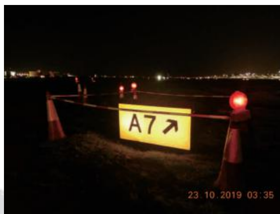
圍封地面設施及掛上紅色閃燈，提醒工人小心留意避免破壞
