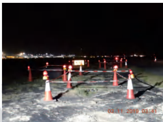
圍封地面設施及掛上紅色閃燈，提醒工人小心留意避免破壞
