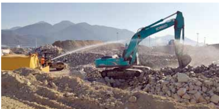
圖7 - 施工時灑水降塵
