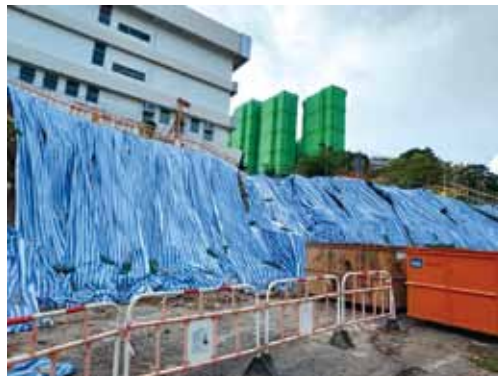
圖2 - 覆蓋暴露的斜坡以防止土壤沖刷，避免雨水流經泥面產生污水。
